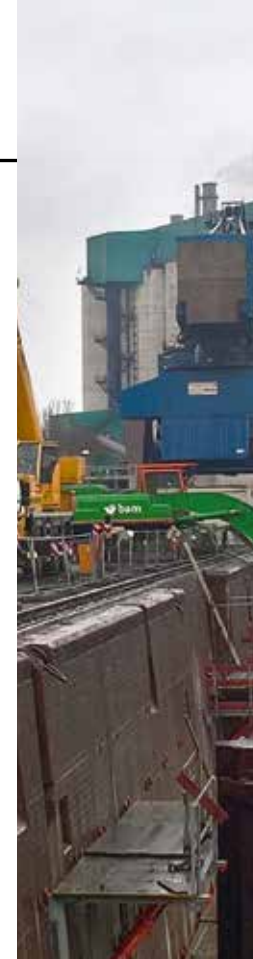
Ufer- und Kaimauern von Kanal- und Hafenanlagen herstellen und sanieren
