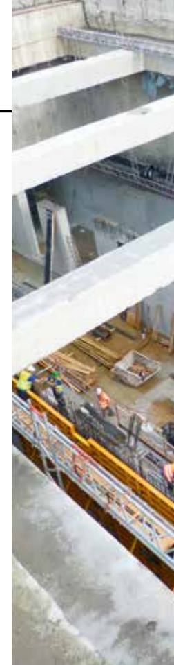
Baugruben für Infrastruktur- projekte wie Bahn- und Straßentunnel, Schleusenanlagen
