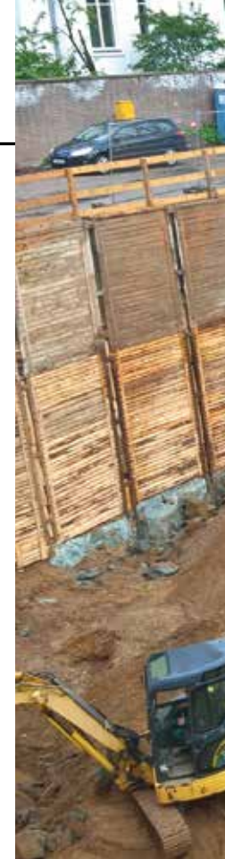
Unterfangungen von Bauwerken Abdichtungen und Bodenverbesserungen
