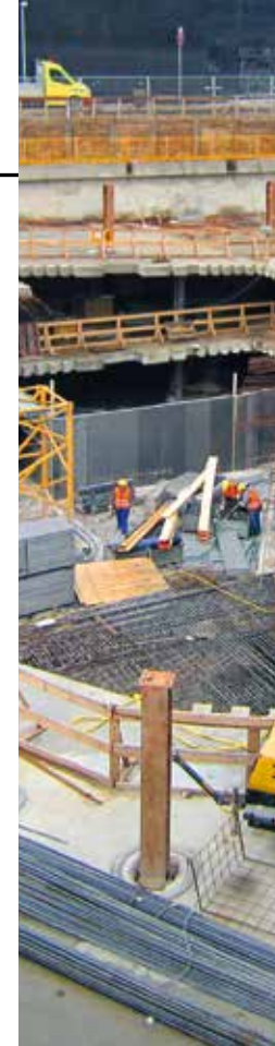
Baugruben auch schlüsselfertig, für Wohn-, Büro- und Industriebau
