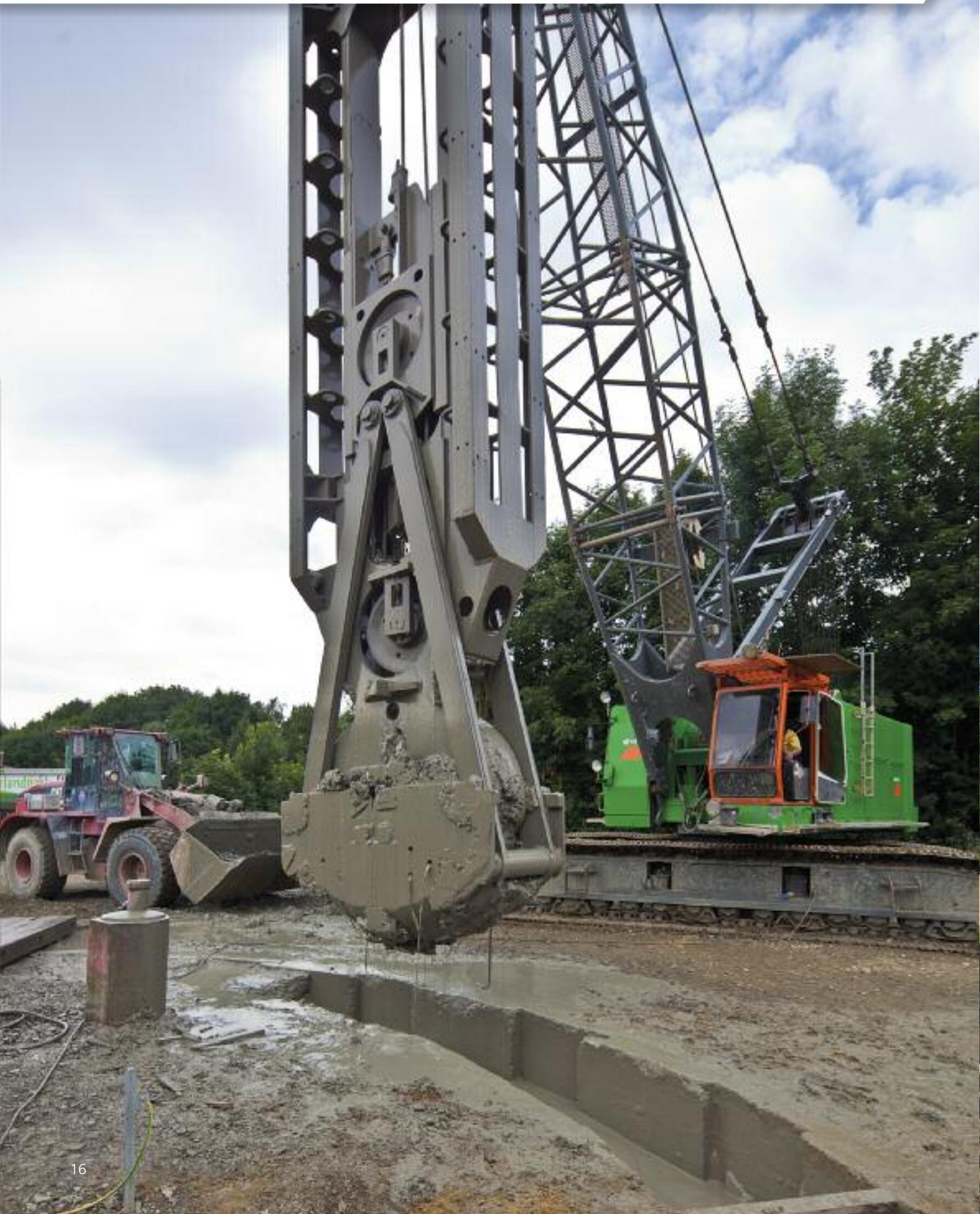
Die Wayss & Freytag Spezialtiefbau GmbH verfügt über das Know-How und die Technik, um Großaufträge wie den Bau des Abwasserkanals Emscher in der dafür vorgesehenen Zeit und der erforderlichen Qualität zuverlässig durchführen zu können. Hierzu zählen z.B. die Techniken zur Erstellung von Bohrpfählen und Schlitzwänden, die für die Herstellung der Baugrubenverbauten beim AKE BA 30 zum Einsatz gekommen sind.
