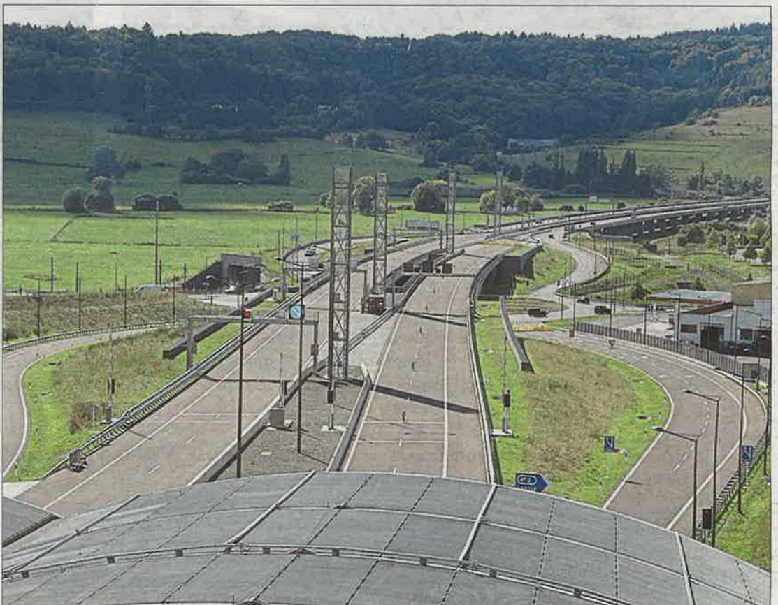
Blick auf die Nordstraße bei Lorentzweiler mit dem Verteilerkreis und dem Alzette-Viadukt im Hintergrund.
