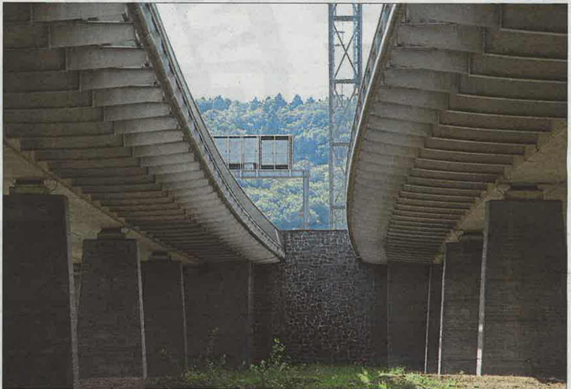
Alzetteviadukt bei Lorentzweiler: Der 890 Meter lange Riesensteg ruht auf nicht weniger als 156 Pfeilern und führt über den Verteilerkreis Lorentzweiler direkt in den Tunnel Grouft.
